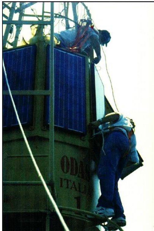
Fig. 6 A - Operazioni di manutenzione ai pannelli solari.
